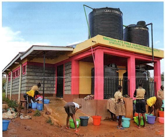
In beiden sanitären Einrichtungen konnten jeweils 14 WC-Anlagen mit integrierten Duschbereichen sowie weitere 14 Duschkabinen errichtet werden. Die vorhandenen Wasserbrunnen wurden repariert und Tauchwasserpumpen installiert, um die Einrichtungen durchgehend mit Wasser zu versorgen.
